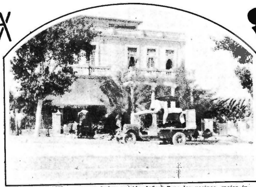
Estas dos casas no parecen haber sufrido daños. Pero los vecinos, mejor informados sin duda, se apresuraron a evacuarlas, en busca de la seguridad que proporcionan los edificios de madera o de "cujes".
